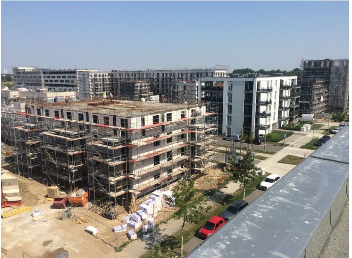
Überblick über das Neubaugebiet "Wohnen am Campus"
