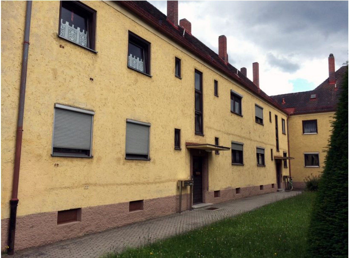
Innenhof mit Blick auf den Ostflügel des Demonstrationsobjekts
